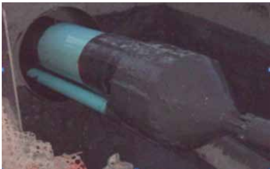
شکل ۴: لوله در خروجی سوراخ و ترتیب و پیکربندی پوشش کششی
