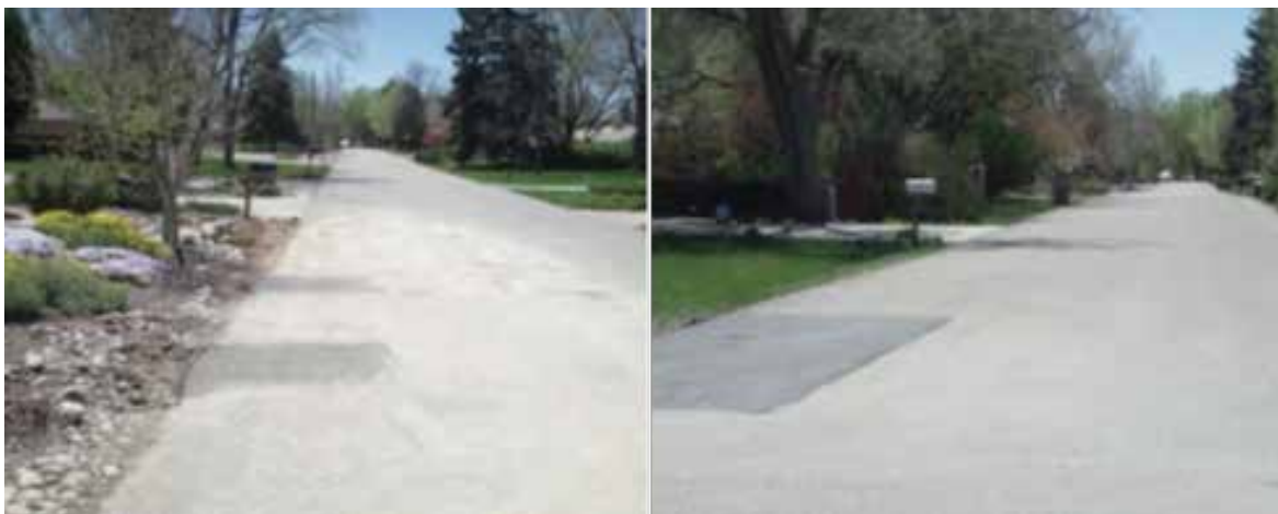
شکل ۷. ترمیم نهایی در مناطقی که ترکیدگی لوله وجود دارد. تکه های آسفالت نسبت به بقیه خیابان نشان داده شده است.
