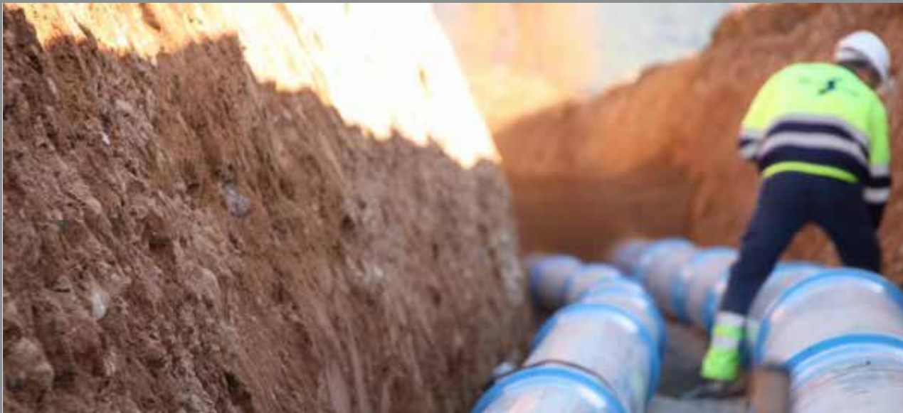
خمش لوله های pvc
